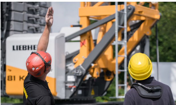
Liebherr-Turmdrehkran auf der Baustelle im Einsatz.
